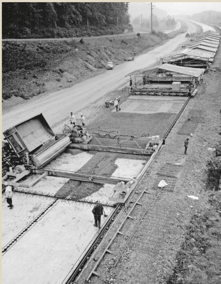
Einbau des Betonbelags an der Autobahn A3 bei Rheinfeldern im Jahr 1964 (Foto: Archiv Rolf Werner/VSS-Chronik 1913–2013).
